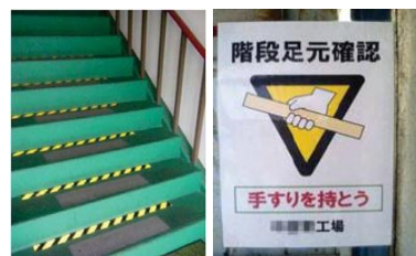
階段の滑止めシールと注意喚起
