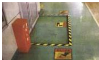
内扉の段差に注意喚起
